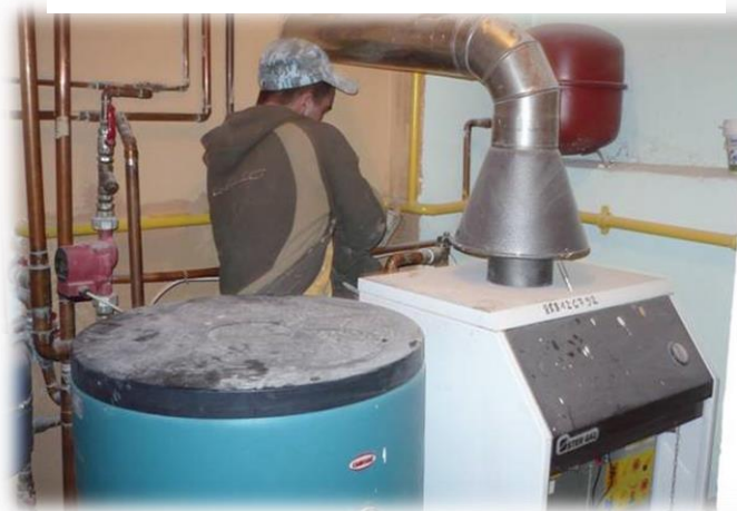
WYMIANA PIECA GAZOWEGO
